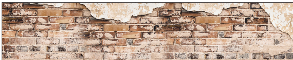
Č. 323 Cihlová stěna
