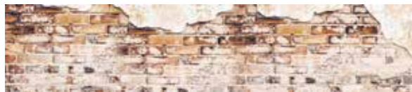
323 mur de briques 323 bakstenen muur
